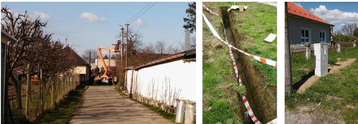
K 2016_147 - 149: Modernizácia osvetlenia v obci dňa 9.3.2016, 8.4.2016, 29.4.2016. Foto: DB
