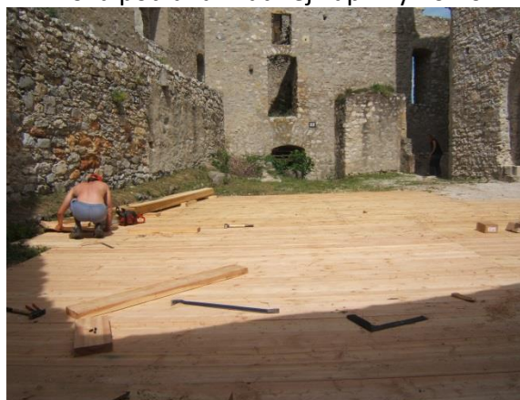
24. Obnova drevenej podlahy na hornom nádvorí
