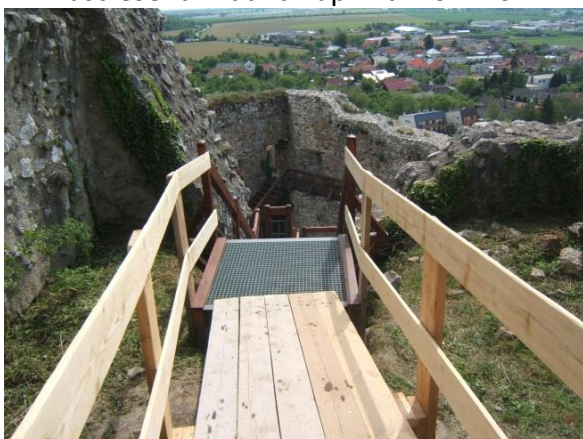
23. Prechod zo schodiska na horné nádvorie
