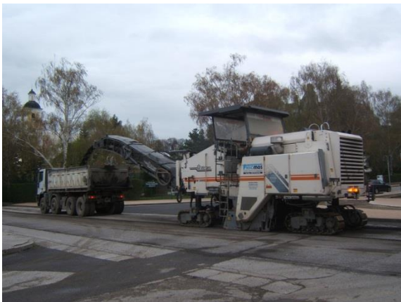
29. Práce na hlavne ceste 17.4.2012
